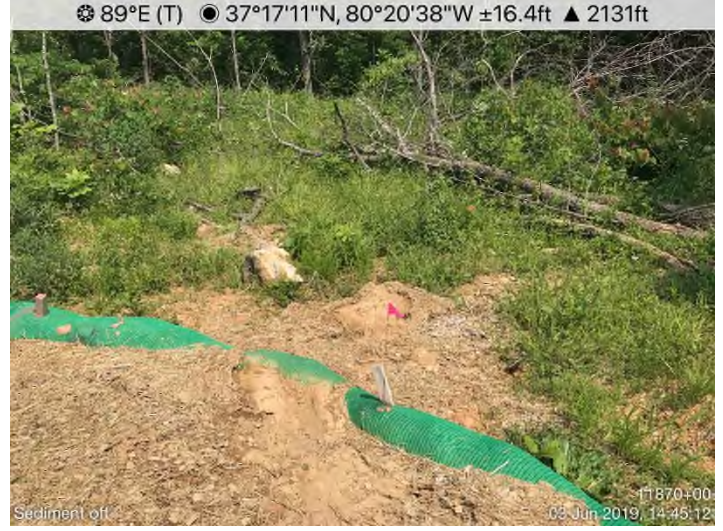
Fig. 10: STA 11870+00 – Sediment off ROW.
