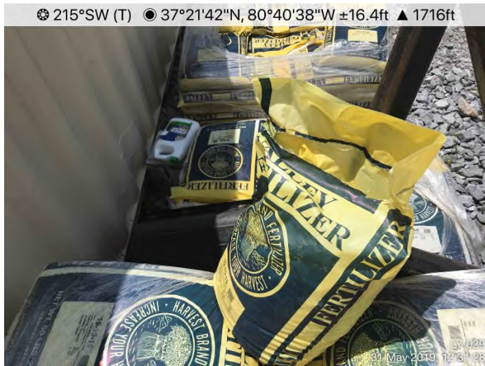
Fig. 3: Laydown Yard 029 – Properly store fertilizer per SWPPP.
